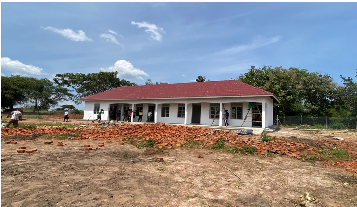
Das neue Schulgebäude in Gwere
